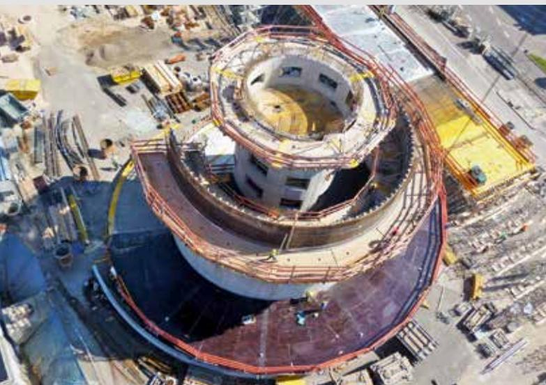
Parkhausspindel mit Auffahrt. Die Abfahrt liegt nicht sichtbar innerhalb der Rundwände. Rechts im Bild die bereits fertige Stegdecke.
