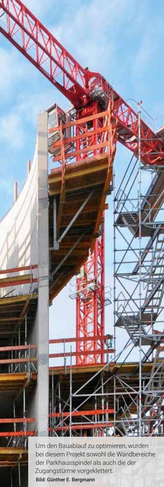
Um den Bauablauf zu optimieren, wurden bei diesem Projekt sowohl die Wandbereiche der Parkhausspindel als auch die der Zugangstürme vorgeklertert.
